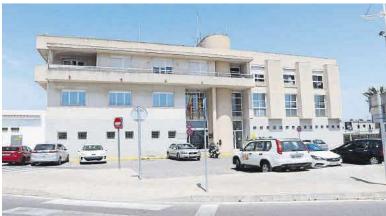
Fachada principal de la sede de la Autoridad Portuaria en Eivissa, donde se encuentra la vivienda afectada.
