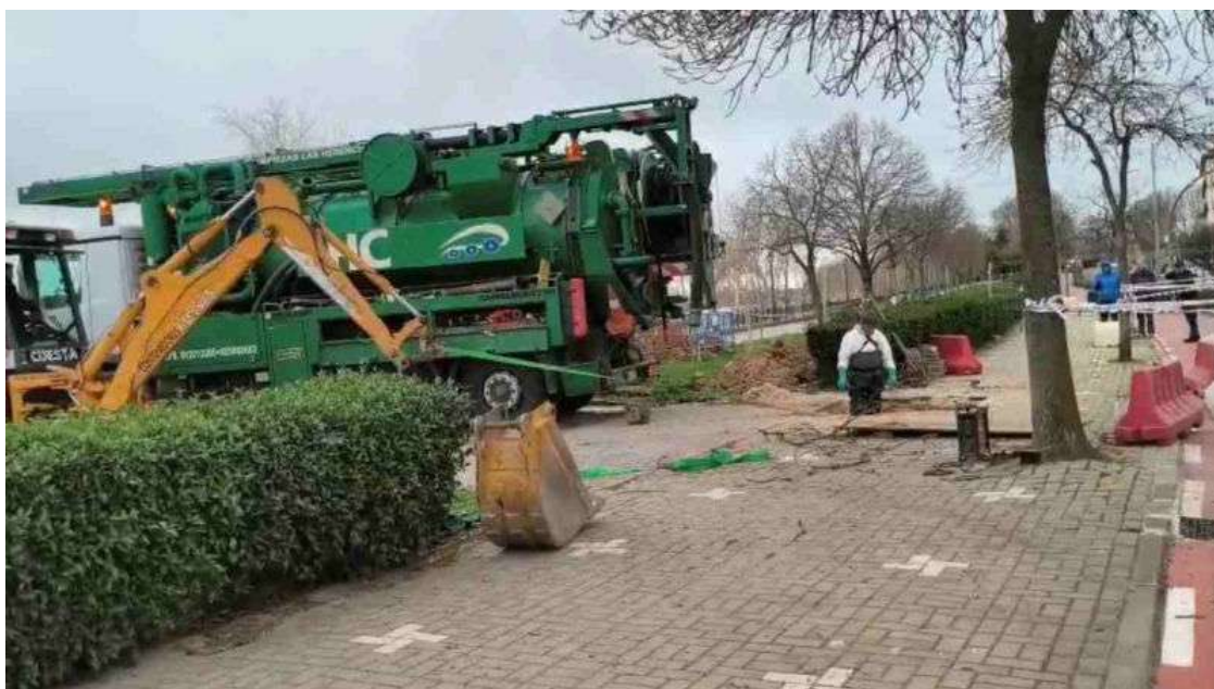
Maquinaria pesada actuando, a toro pasado, en la limpieza de los colectores de Talavera de la Reina. EP.
