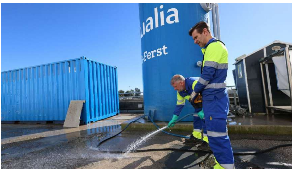
Operarios de Aquajerez, quitando barro en la depuradora de El Portal. JUAN CARLOS TORO
