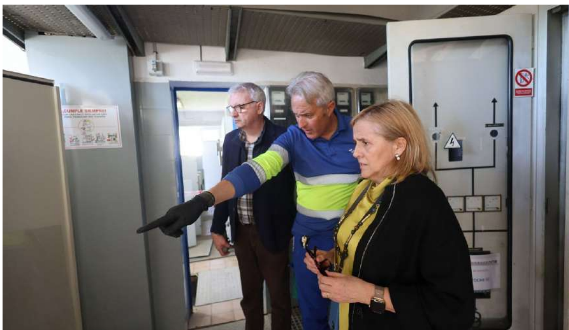
Un operario muestra a Antonio Gragera, jefe de servicio, y a Lola López, gerente de Aquajerez, el desarrollo de los trabajos de recuperación.
